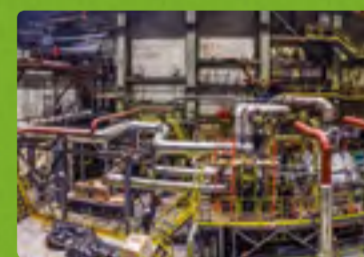
Испытательный стенд для паровых турбин
