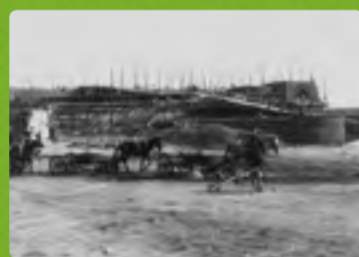
Строительство доменного цеха (1898 г.)
