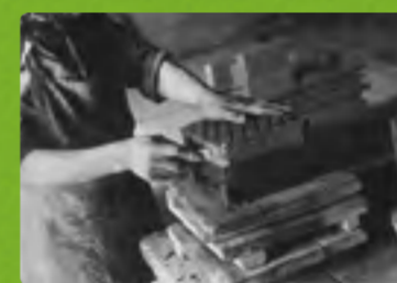
Изготовление половых плиток (1933 год)
