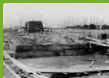
Укладка фундаментов под сооружение комплекса доменной печи (1897 г.)
