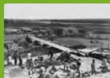
Общая панорама строительства Сокольского завода (1898 г.)
