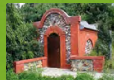
Вход в подземелье — каптаж Кувака (гидротехническое сооружение XIX в., объединившее 7 знаменитых водных источников)
